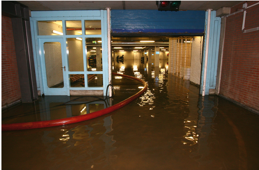
FIGUUR 1 Overstroming van de parkeergarage van het VUmc op 8 september 2015, na een breuk in een hoofdwaterleiding van Waternet (foto: Angelique Broerse-van Hal).
